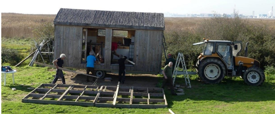
Les bâtiments d'accueil de l'Acro'pôle sont amovibles afin de laisser le milieu naturel tel quel le reste de l'année (2017)
