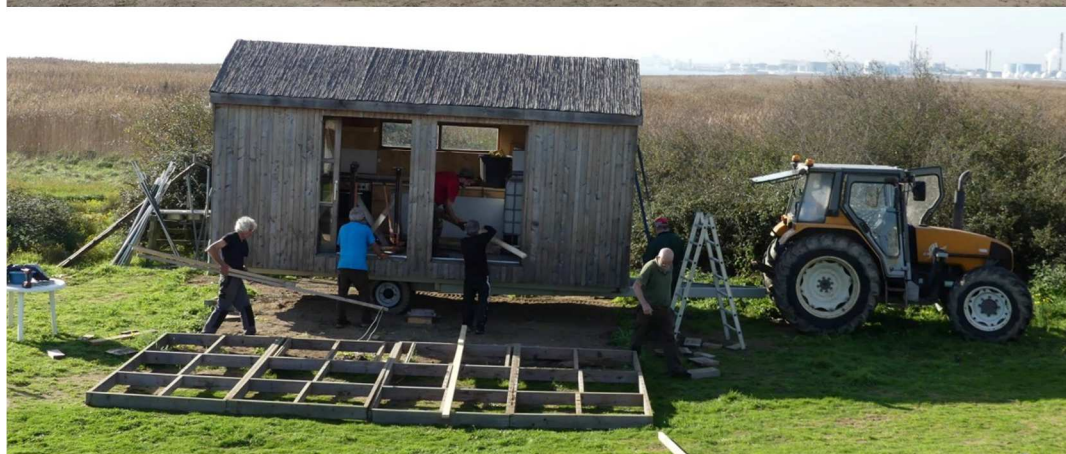
Photo 5 : Les bâtiments d'accueil de l'Acro'pôle sont amovibles afin de laisser le milieu naturel tel quel le reste de l'année
